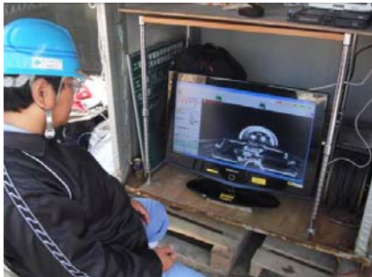
写真-3 掘進中の動画監視の様子
