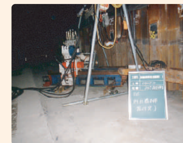
削孔機据付完了
