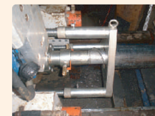
スปีダー機での圧入掘削状況
