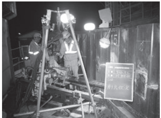
写真-3 施工全景
