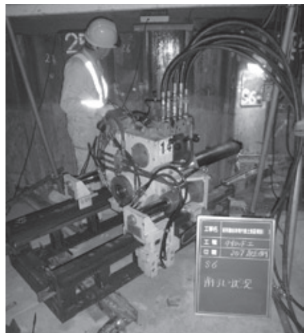
写真-1 スピーダー機での圧入掘削状況
