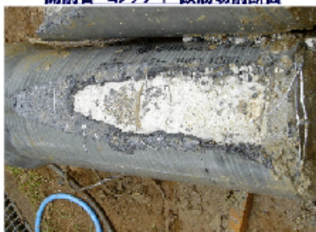
斜め進入推進後の管切削状況
