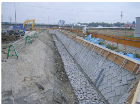
ブロック積施工状況
