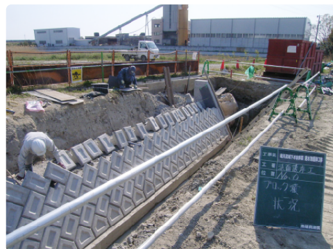
ブロック積施工状況
