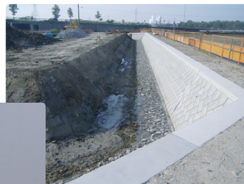
ブロック積完了
