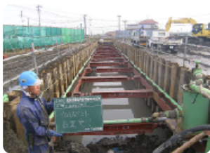
木更津φ2800 HP部施工全景
