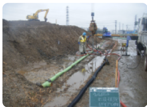
吉川ウエルポイント打設状況
