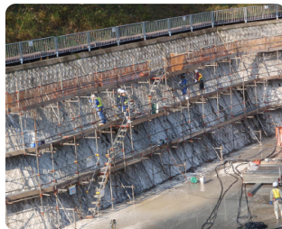
注入状況(全景)
