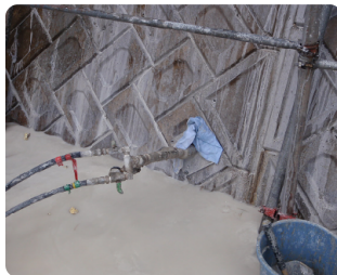
注入状況(近景)
