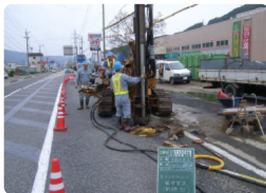
パーカッション据付
