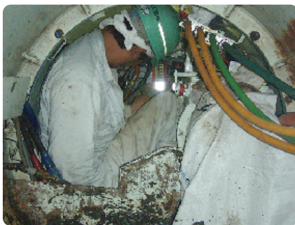
マシン操作状況
